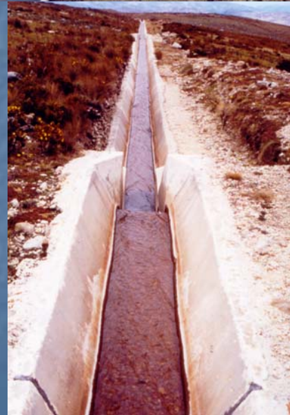
CANAL LA SHACHSA
